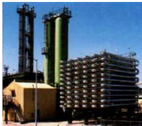
Procédé Dimersol de transformation du propylène en isohexènes utilisés comme booster d'octane pour les essences.
